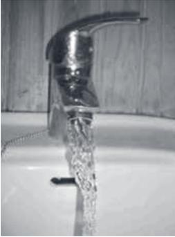
Lorsque votre robinet coule mal, il convient de nettoyer la tête car elle est obstruée par du calcaire. Il suffit pour cela de la nettoyer avec un produit anti-calcaire ou du vinaigre d'alcool chaud.
